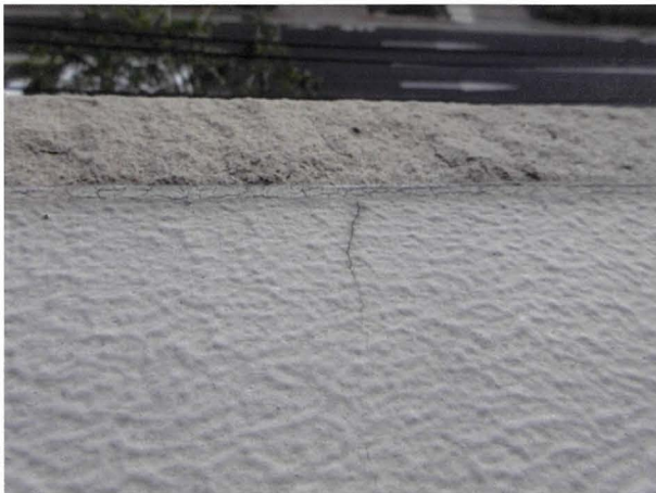
3. 逆梁天端ひび割れ
