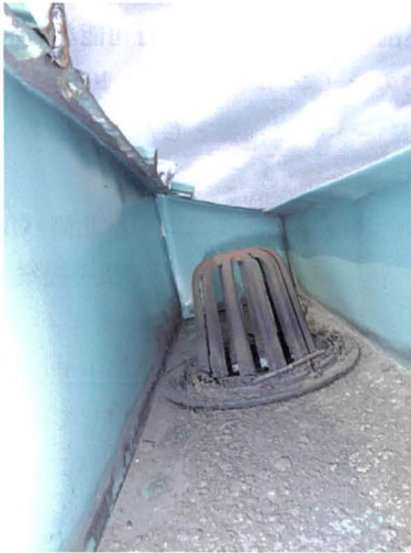
3. ポールト屋根樋部分の納まり
