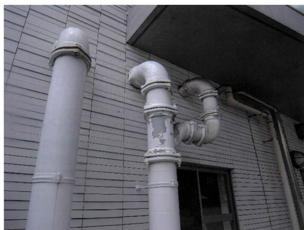
2. 配管塗膜剥離
