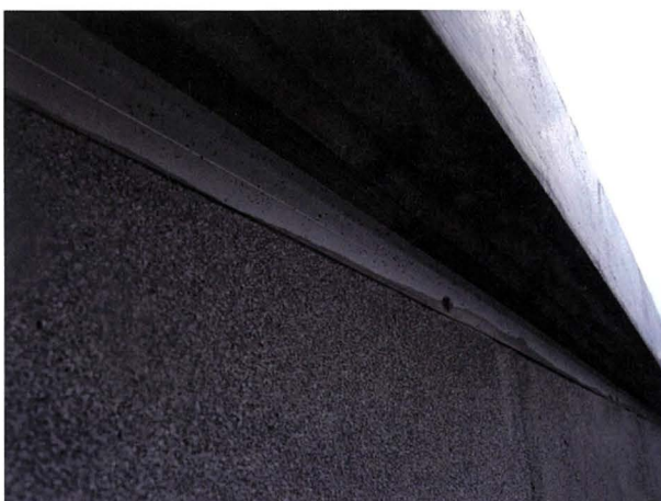
2. 防水立ち上がり端部の破断
