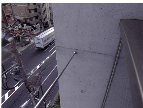
4. 柱打部分ひび割れ（震災の影響）
