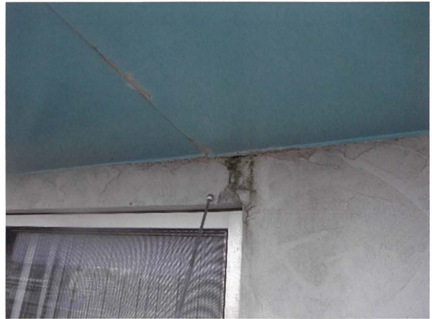
4. 8 F 底板金部分より漏水
