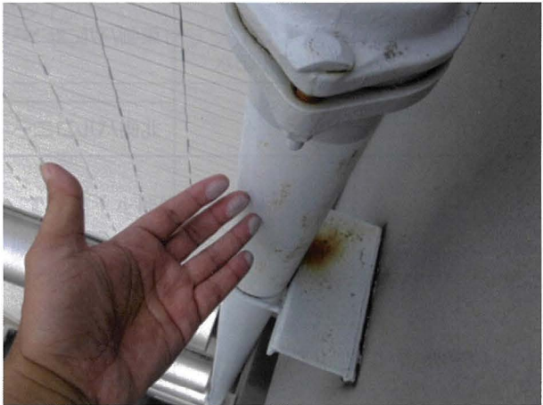
6. 連結送水管 塗膜のチョーキング
