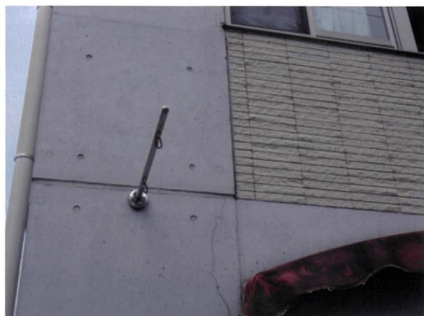
1. 柱梁取り合いひび割れ（震災の影響）
