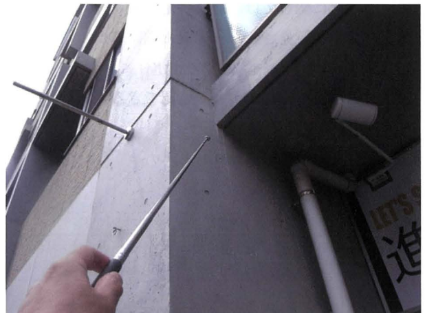
6. 東側バルコニー天井からのひび割れ、漏水
