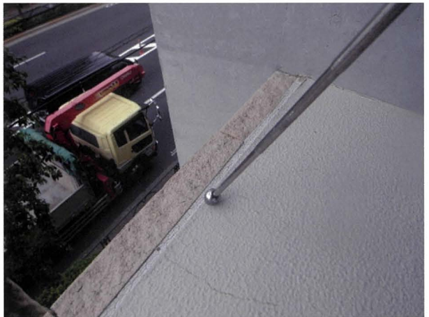
4. 逆梁天端ひび割れ
