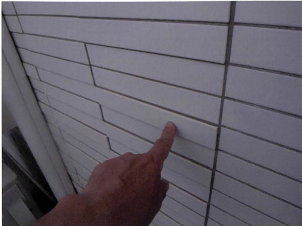
5. 北面6F漏水部分目地埋
