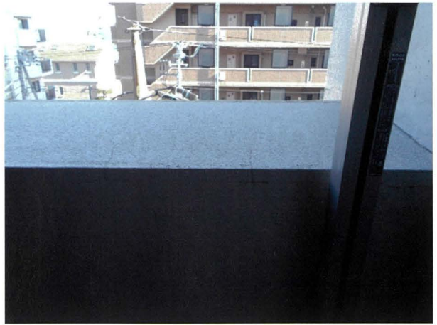
2. 逆梁天端ひび割れ
