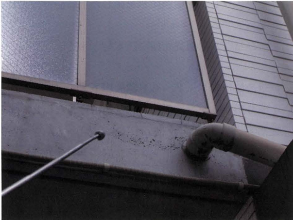
3. 北側バルコニー天端のひび割れ
