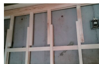
パネル高は、補助木枠を組み合わせることで調整が可能に。
